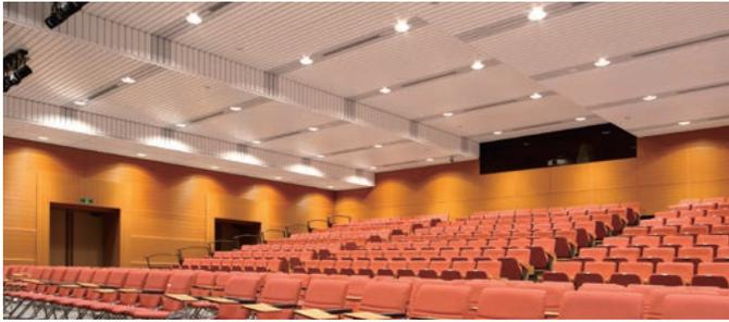
グラスウール等の裏打ち材を使用せず、アルミニウムのみで構成された吸音仕上材。空間内で、音の無駄な反射を防ぐことで、快適な音環境をつくります。
