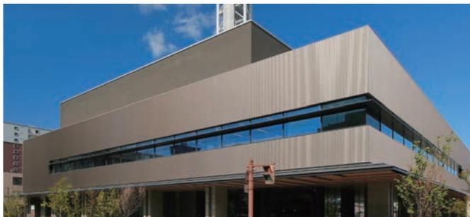
大胆なデザインで建物の外観をデザインするスパンドレルアウトサイドシステムは、軽快な施工性と低コストで外装材の選択肢を広げます。豊富なデザインバリエーションと、様々な納まりに対応するボーダーで建物を美しく仕上げ、アルミ製なので軽量で耐食性にも優れています。規格品形状以外のオリジナルデザインにも対応します。
