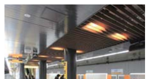
駅舎・空港建築 点検口
