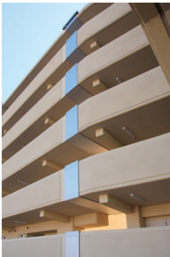
大阪府営住宅
