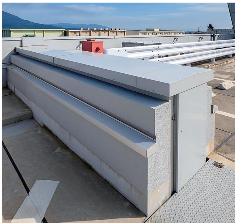
屋上 1工区、2工区との接続部
