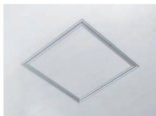
内装ビジネスユニット/点検口
