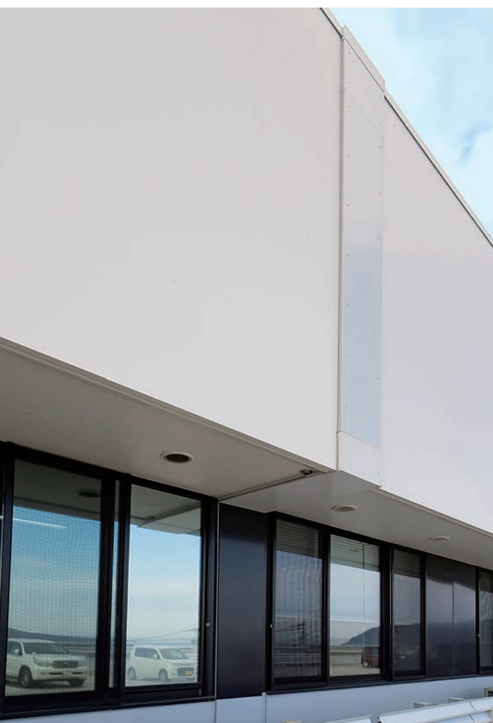
外壁・大庇 1工区、2工区との接続部
