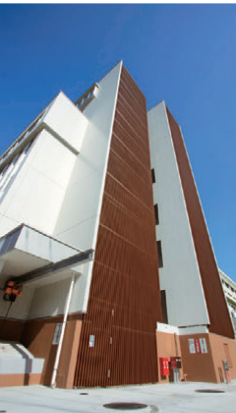
木目シート / WTA-602 (ピンテージウォールナット) スカイフィット / SHS-3010 庄原赤十字病院 (広島県)
