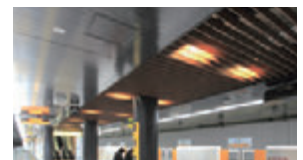
駅舎・空港建築 点検口
