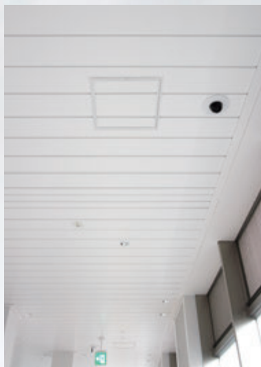
天井点検口／RC型 南北自由通路（静岡県）
